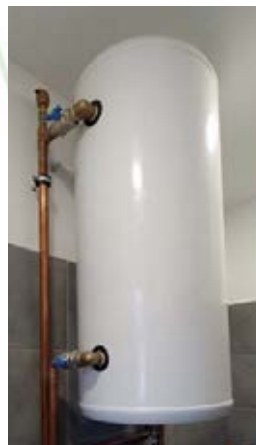
Rézcsővel csatlakoztatott melegvítartó, hiányzik: tároló földelés és dielektromos közcsavar (plusz táglulási tartály).
